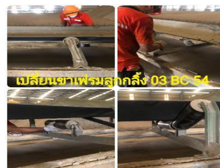
ตรวจสอบหน้างาน งานงานเปลี่ยน เฟรมลูกกลิ้ง 03BC54
