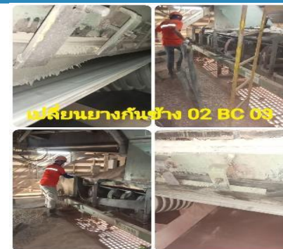
ตรวจสอบหน้างาน งานงานเปลี่ยน ยางกันข้าง 02BC03
